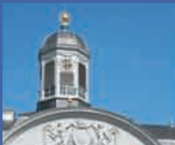
Photo de couverture : Detail de l'Hôtel de Ville
