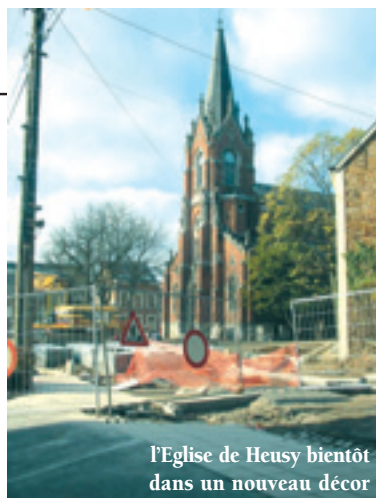
rue de la Tannerie à Mangombroux : les ornières font partie du passé
