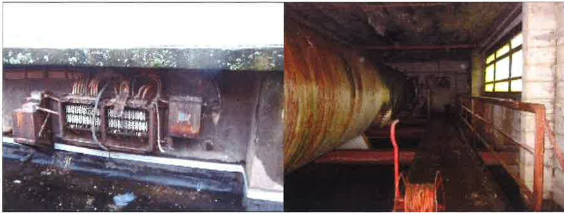
Pendant et après les travaux :
