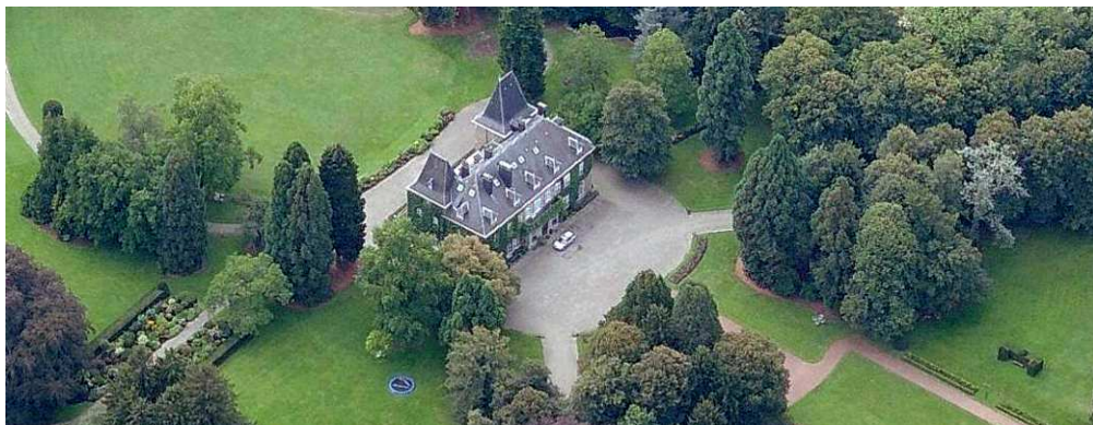
LE CHATEAU DE LAMBERMONT, SITUE RUE TRIBOMONT – SOURCE : WWW.BINGMAPS.BE
